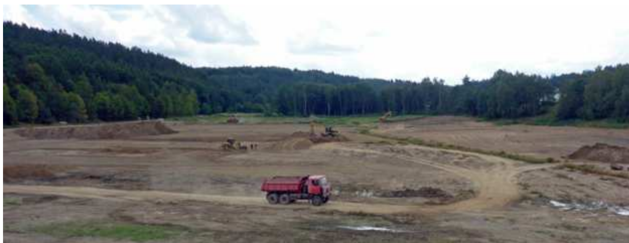
Obrázek 1 Rekonstrukce vodní nádrže Sedlinka
