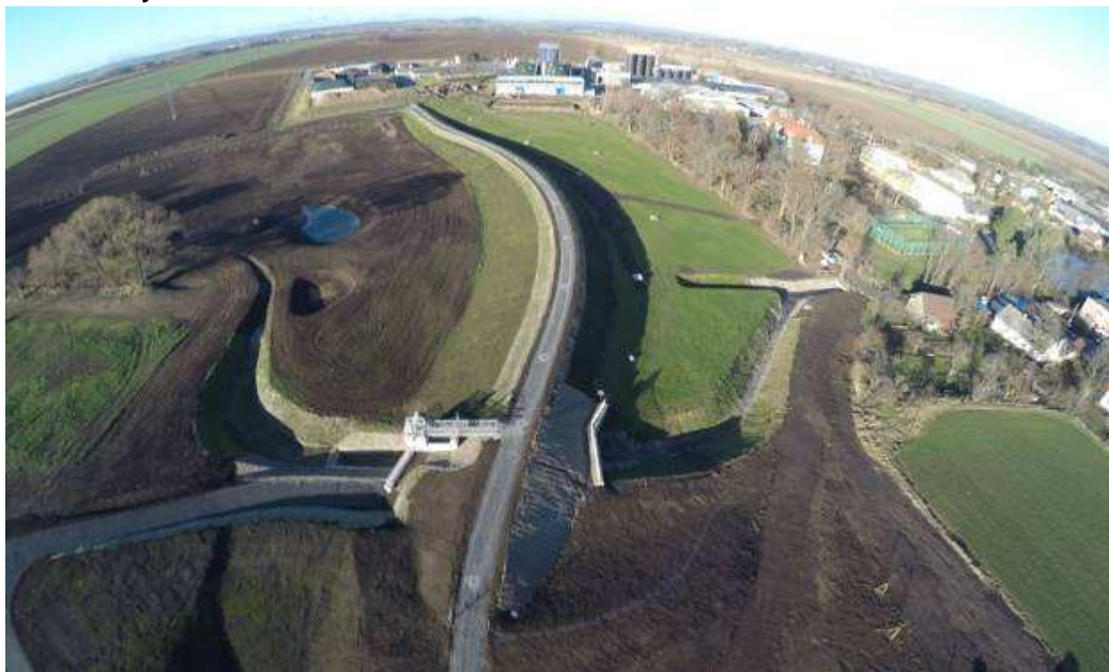
Obrázek 6 Výstavba suché retenční nádrže Loděnice
