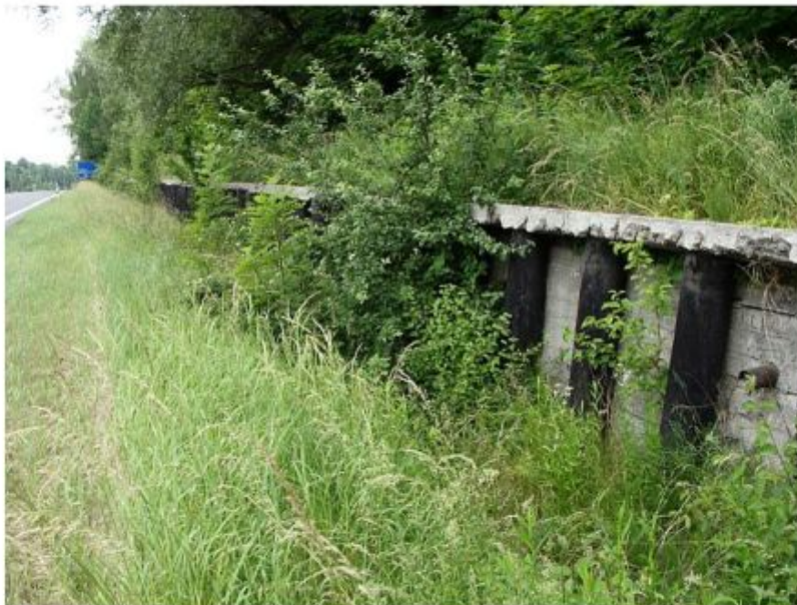
Obrázek 4: Detail opěrné zdi s odvodňovacím prvkem
