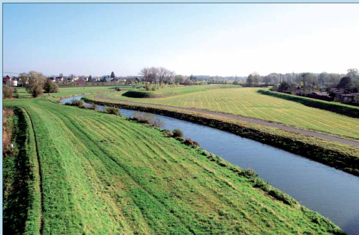
➤ Odstranění návozu z pravobřežního prostoru řeky Opavy nad trať ČD Opava - Hlučín se zvýšil stupeň ochrany před povodněmi na dolním konci městské úpravy přes Opavu.
