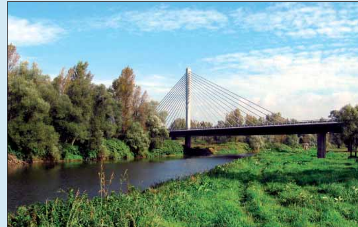
▲ Dálniční most (dálnice D1) přes řeku Odru pod Ostravou.
