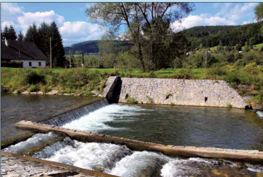
▲ Všechny nové nebo rekonstruované spádové objekty jsou vybavovány rybími přechody. Štuceň na řece Opavě v Karlovicích.
