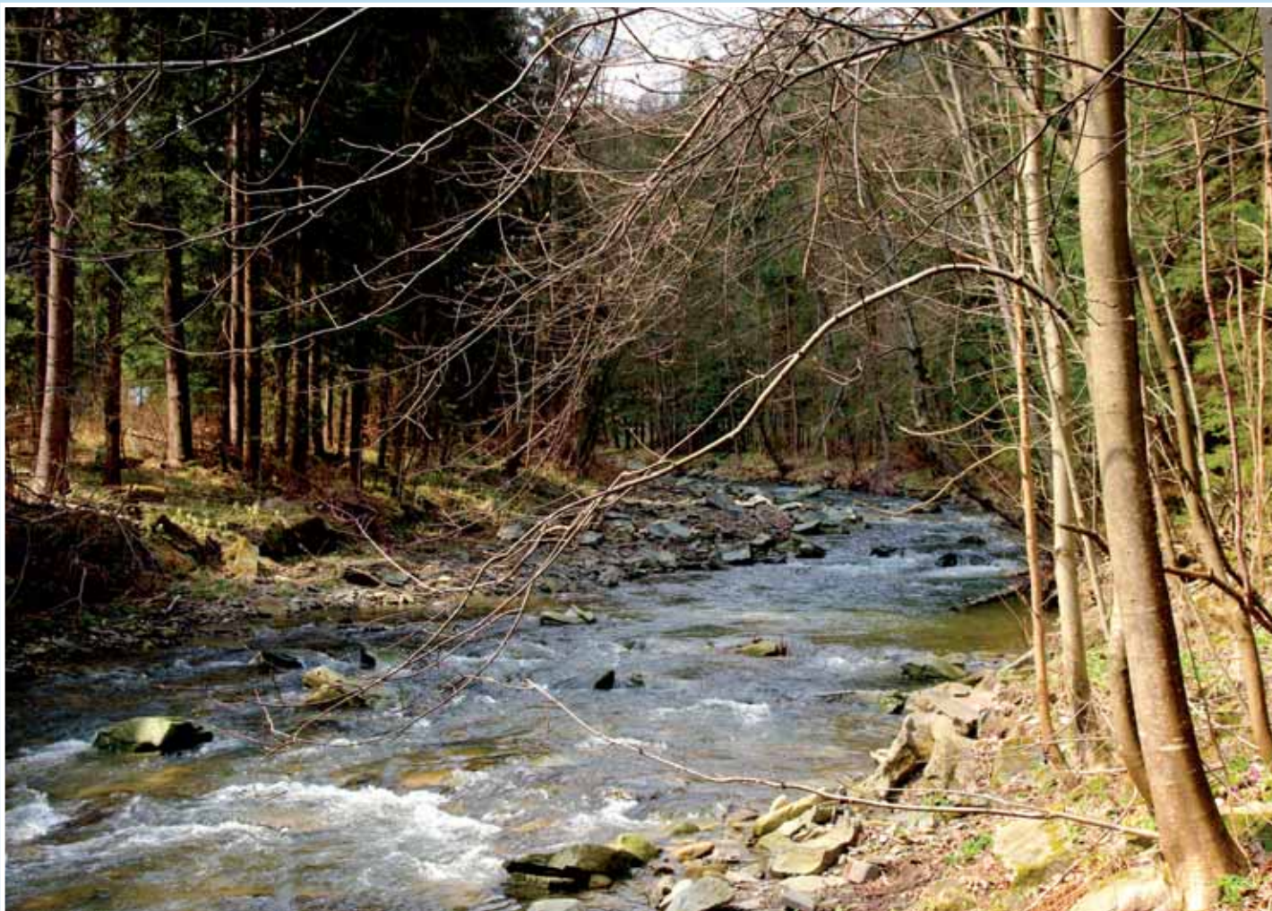
Bystřina Lomná stabilizovaná před 50 lety pohozem dna balvany ke zvýšení účinné drsnosti koryta.
