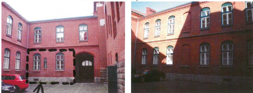
Pohled na budovu č. p. 378 ze dvora
