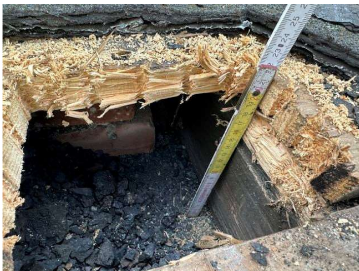
Foto 5: Pohled na skladbu střešního pláště v místě sondy S1
