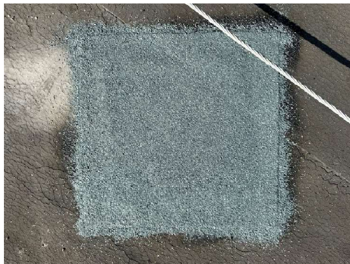
Foto 25: Pohled na zapravení sondy S2 – horní pás
