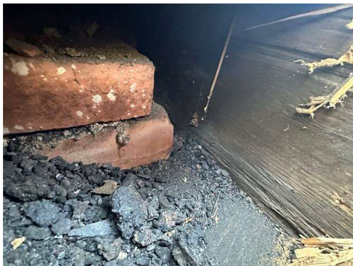
Foto 7: Pohled na způsob uložení krokve na obvodovou stěnu
