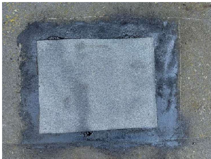
Foto 8: Pohled na zapravení sondy S1 – spodní pás
