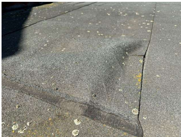
Foto 10: Pohled na zvlnění povlakové hydroizolace
