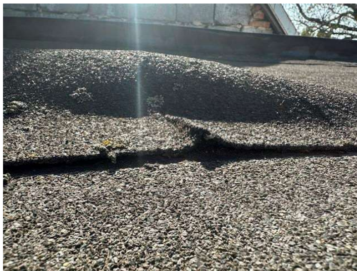
Foto 11: Pohled na výrazné zvlnění povlakové hydroizolace v blízkosti jejího spoje
