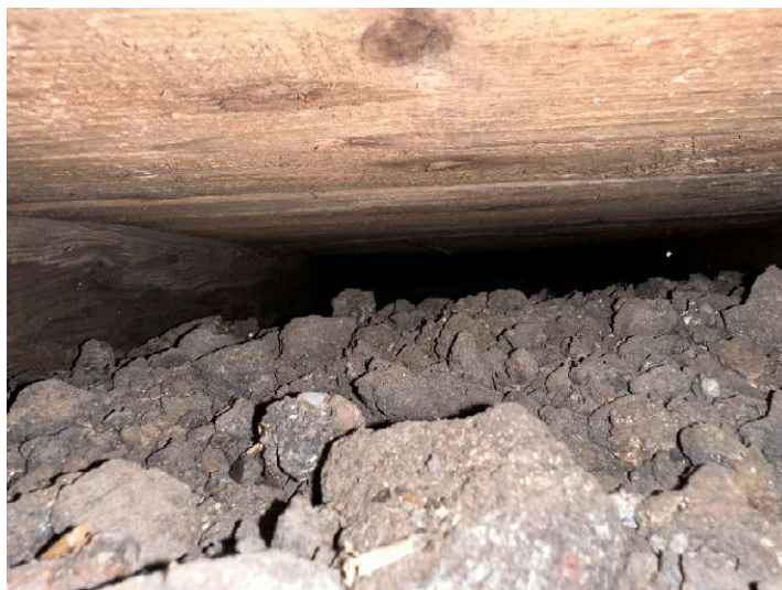
Foto 15: Pohled na vrstvu násypu strusky mezi krokvemi
