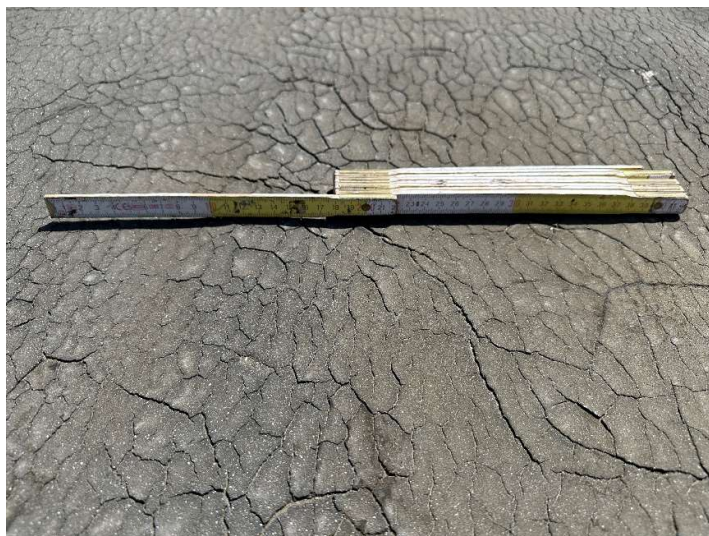
Foto 30: Pohled na tvorbu trhlin v ploše asfaltových pásů
