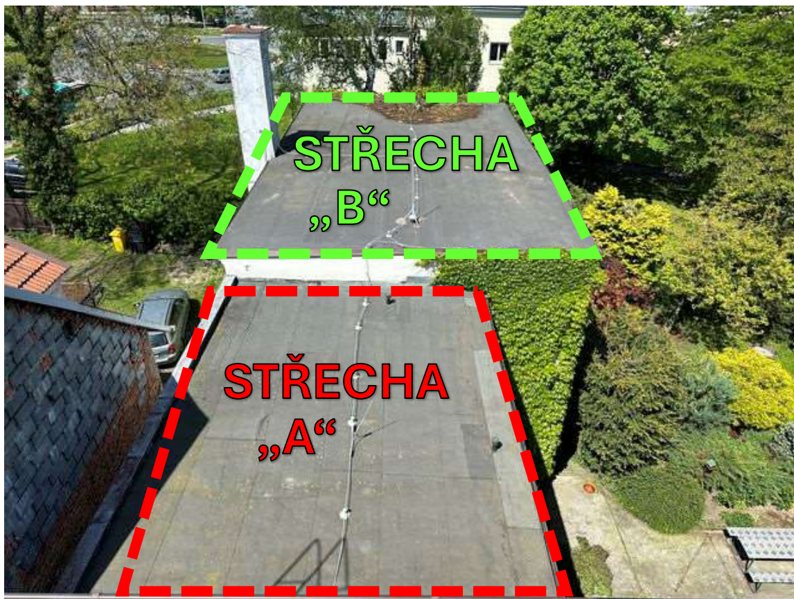
Foto 1: Rozdělení předmětných plochých střech objektu pro účely tohoto posouzení Střecha A (nižší střecha) – vyznačena červenou barvou (dřevěná nosná konstrukce) Střecha B (vyšší střecha) – vyznačena zelenou barvou (železobetonová nosná konstrukce)
