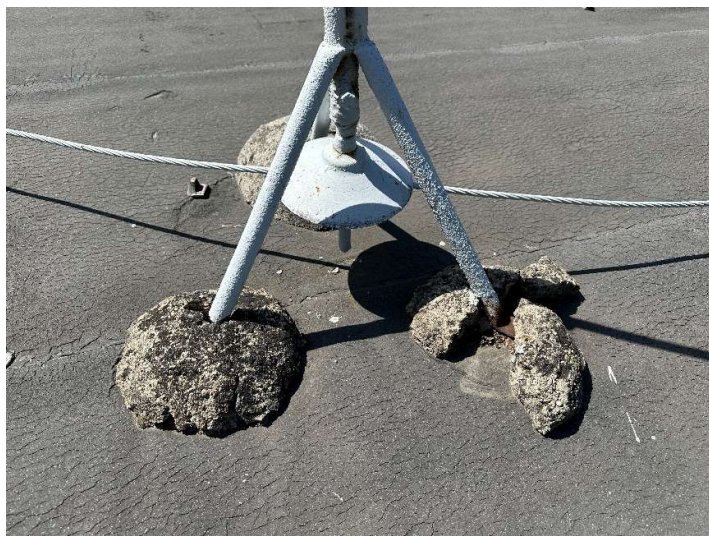
Foto 33: Pohled na degradované betonové prvky
