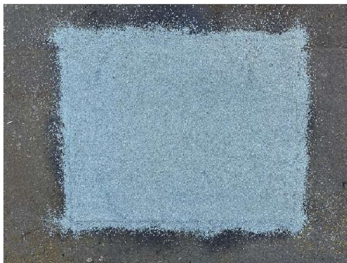
Foto 9: Pohled na zapravení sondy S1 – horní pás
