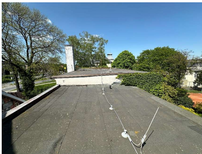
Foto 18: Pohled na bleskosvodnou soustavu
