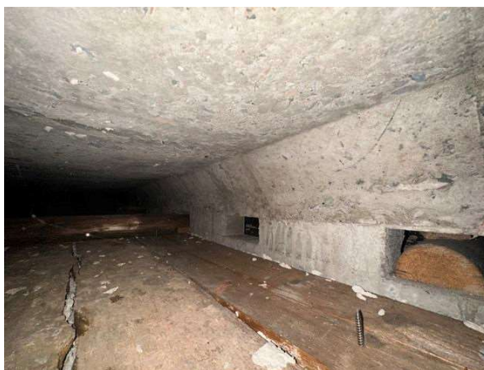
Foto 28: Pohled do mezistřešního prostoru nad původním podhledem z dřevěných prken s rákosovou omítkou
