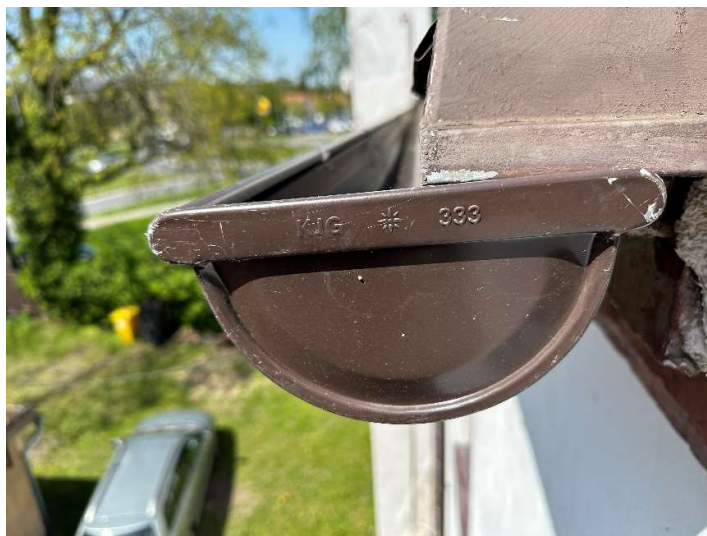
Foto 17: Pohled na půlkruhový podokapní střešní žlab
