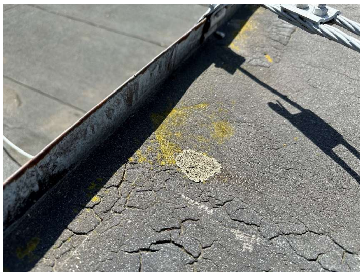
Foto 31: Pohled na lokální odhalení nosné vložky asfaltových pásů
