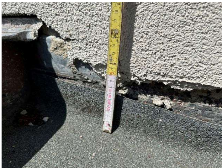
Foto 12: Pohled na absenci opravy vytažení hydroizolace na navazující konstrukci stěny
