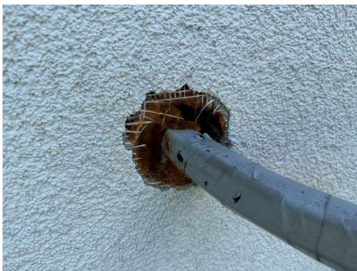
Foto 14: Pohled na způsob opravy prostupu kabeláže stěnou objektu montážní pěnou
