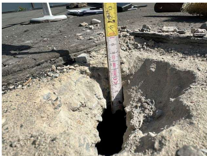
Foto 22: Pohled na skladbu střešního pláště v místě sondy S2
