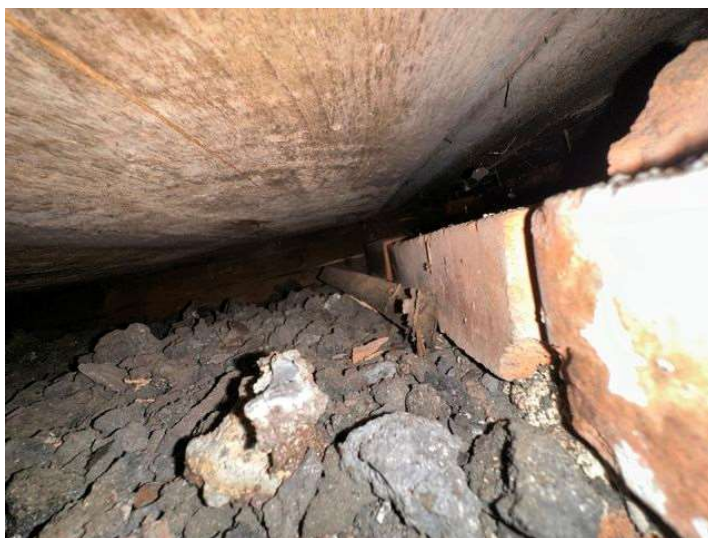
Foto 6: Pohled do prostoru střešního pláště, pohled na zděnou část atiky z cihel plných pálených
