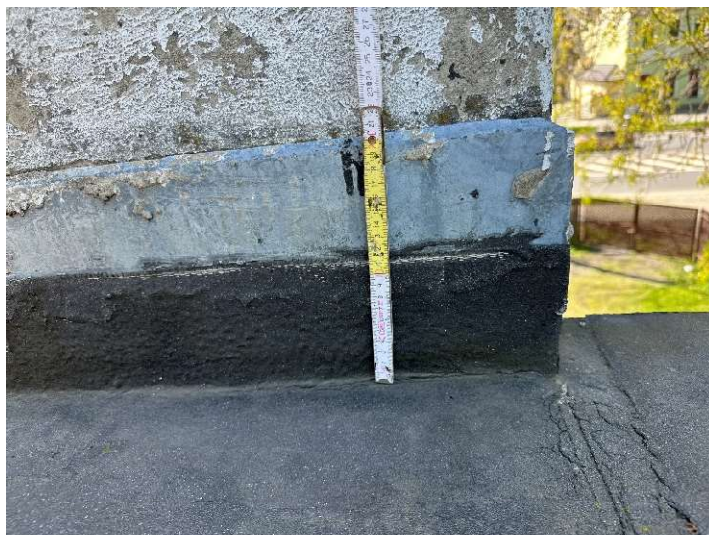
Foto 34: Pohled na vytažení povlakové hydroizolace na těleso komínu
