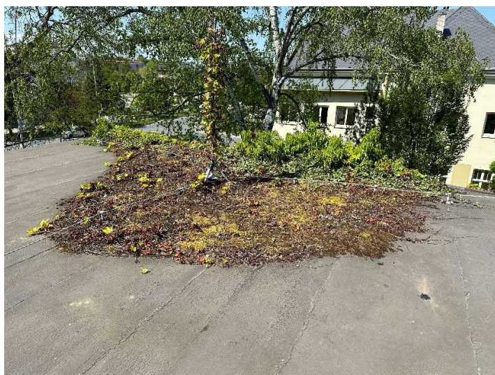
Foto 32: Pohled na růst vegetace na střešním plášti
