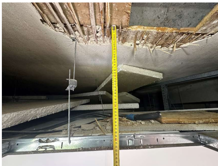
Foto 36: Pohled na vrstvu střešního pláště nad podhledem v místě sondy S3
