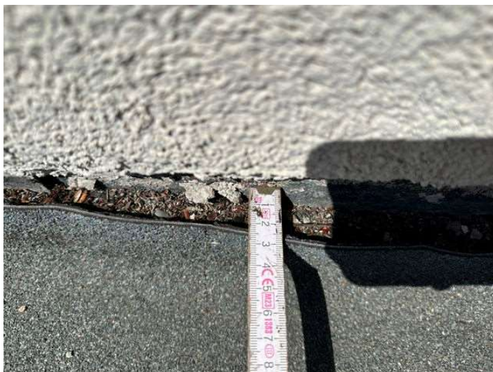
Foto 13: Detail netěsnosti mezi ukončením povlakové hydroizolace a navazující stěny
