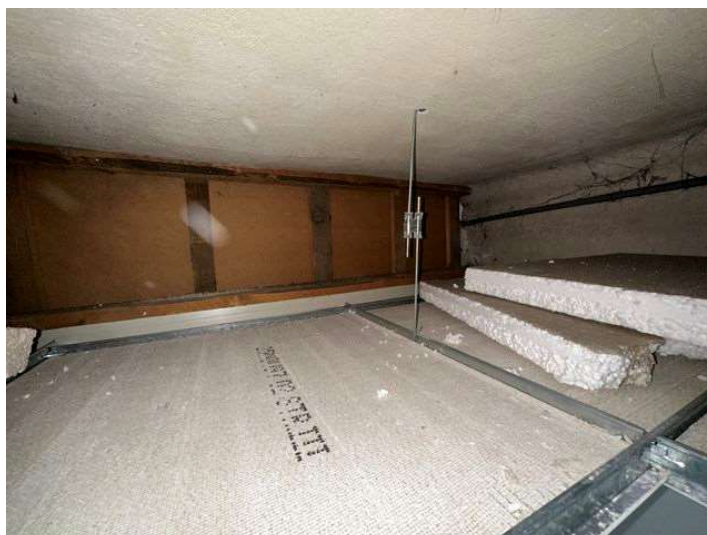
Foto 27: Pohled do prostoru nad skládaným podhledem s nosným roštem
