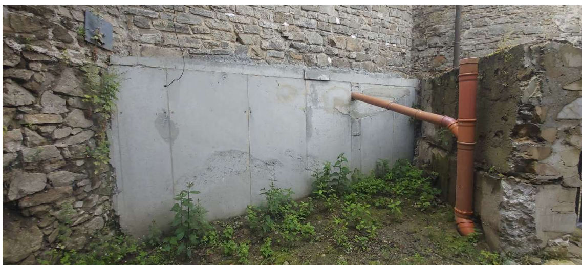
3. Část prostoru s podbetonováním zdi WC a s kanalizačním vedením
