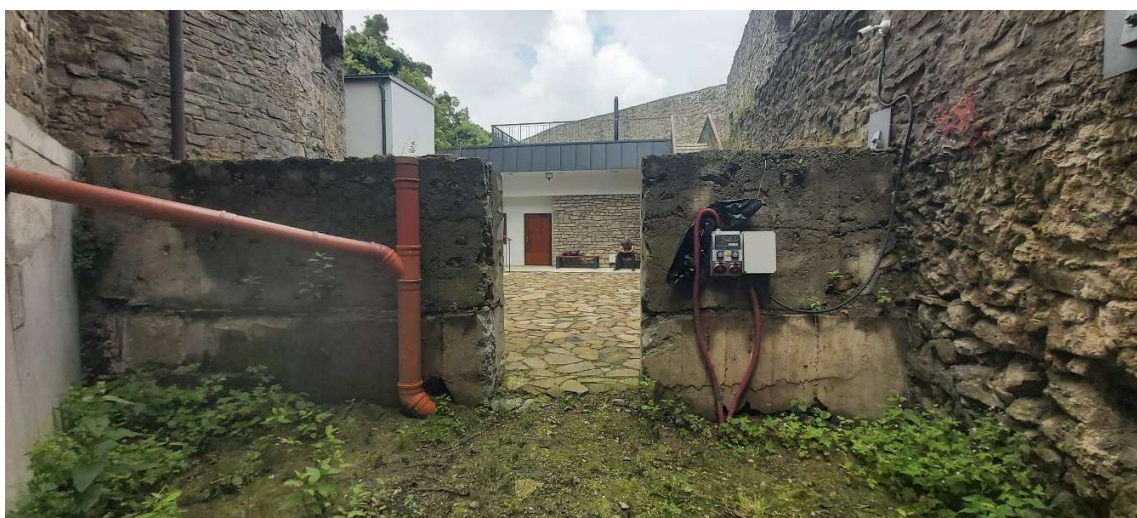
4. Vnitřní líc dělicí zdi s vyříznutým otvorem, vlevo kanalizace, vpravo el. rozvaděč
