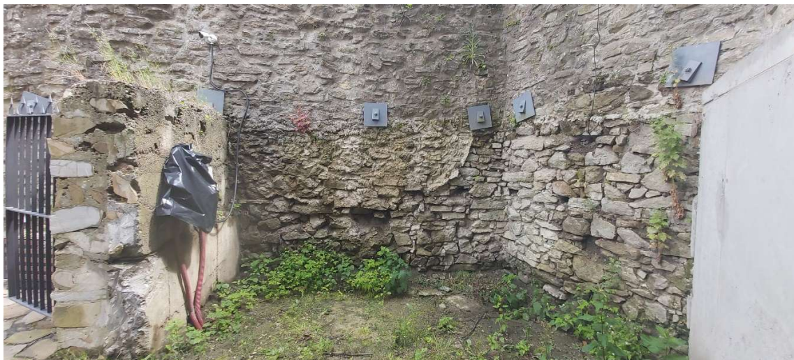
2. Část prostoru u hradeb SZ bastionu s kotvami táhel
