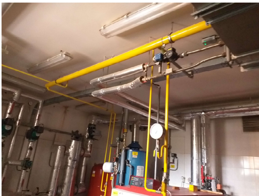
Směšovací uzel pro vzduchotechnickou jednotku
