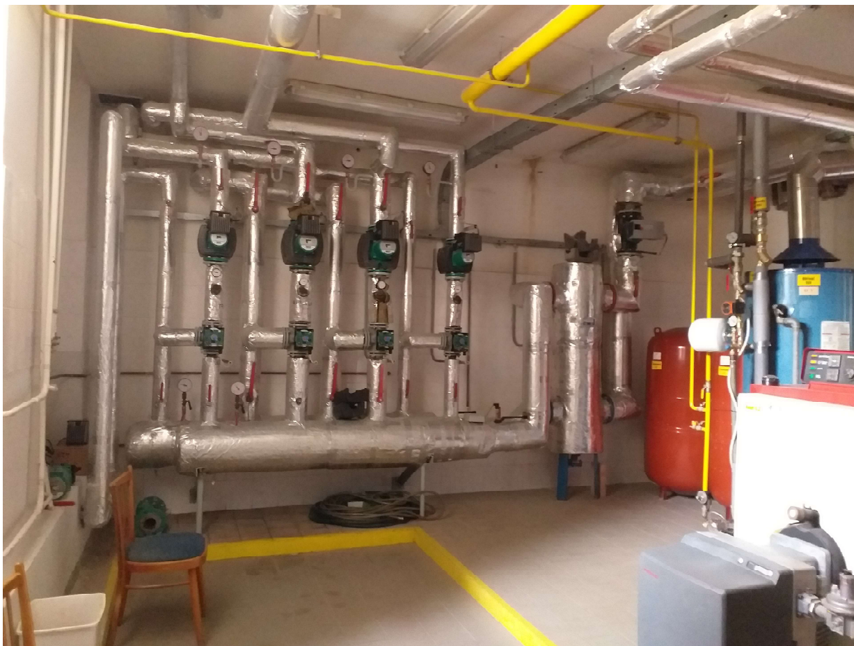
Rozdělovač a sběrač otopné vody, anuloid
