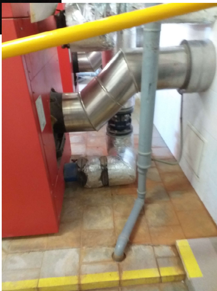
Odvod spalin a napojení přepadu pojistného ventilu do kanalizace
