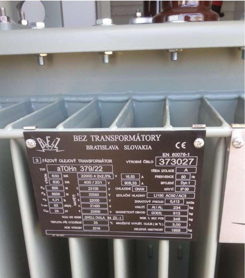
Foto specifikace transformátoru instalovaného v trafostanici
