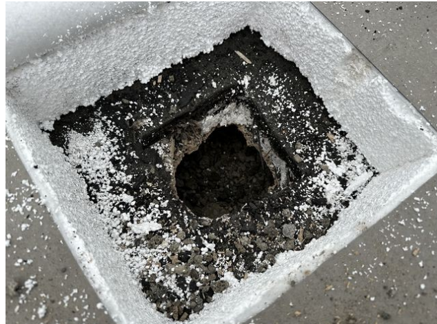
obr. /16/ Pohled do místa provedené sondy S3 (odstraněna část dodatečného zateplení)
