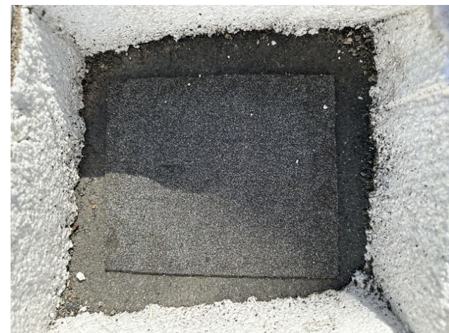
obr. /18/ Pohled na zapravení sondy S3 – v úrovni původního souvrství střechy
