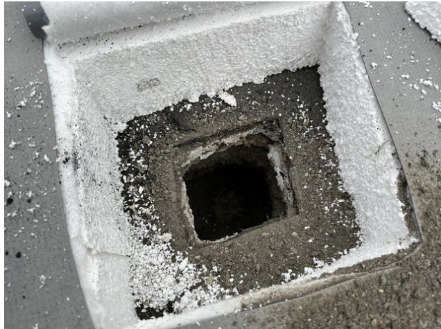
obr. /10/ Pohled do místa provedené sondy S2 (odstraněna část dodatečného zateplení)
