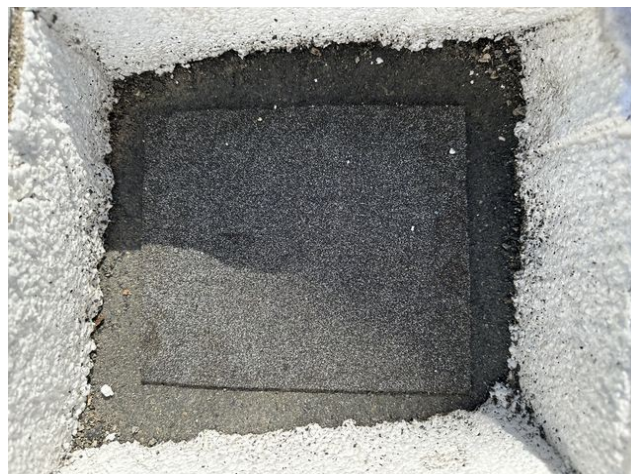
obr. /12/ Pohled na zapravení sondy S2 – v úrovni původního souvrství střechy
