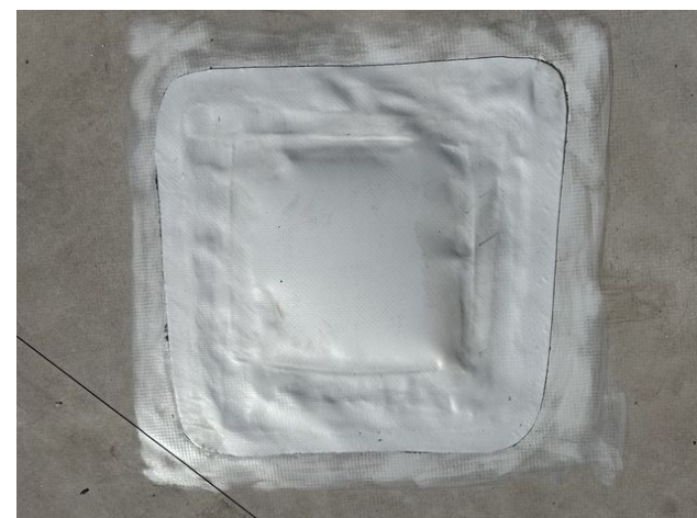
obr. /20/ Pohled na zapravení sondy S3 – horní pás
