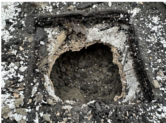
obr. /5/ Pohled na provedenou sondu S1 – přes původní souvrství
