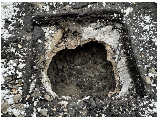
obr. /17/ Pohled na provedenou sondu S3 – přes původní souvrství
