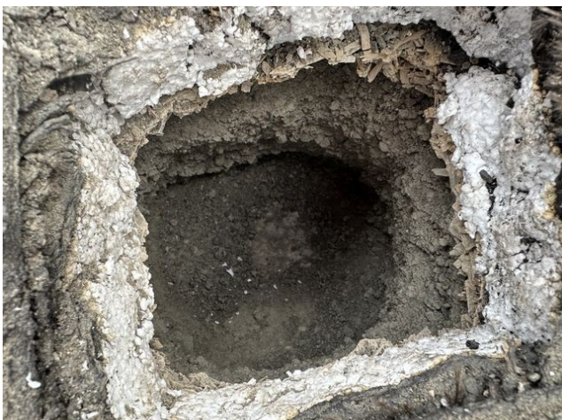
obr. /11/ Pohled na provedenou sondu S2 – přes původní souvrství
