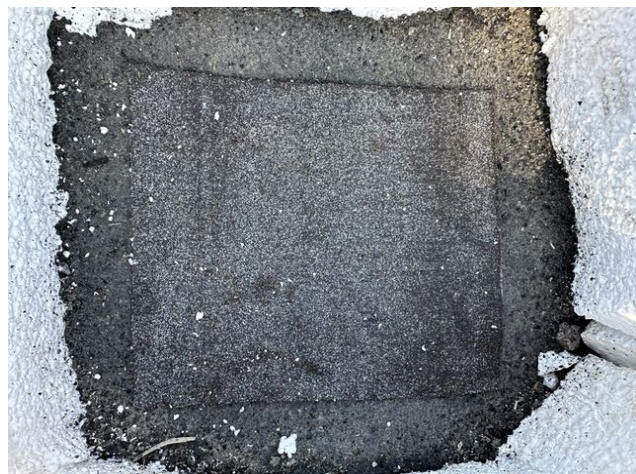
obr. /6/ Pohled na zapravení sondy S1 – v úrovni původního souvrství střechy
