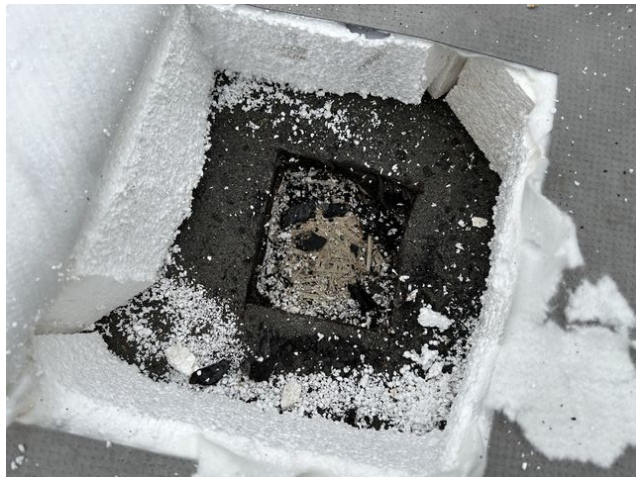
obr. /4/ Pohled do místa provedené sondy S1 (odstraněna část dodatečného zateplení)
