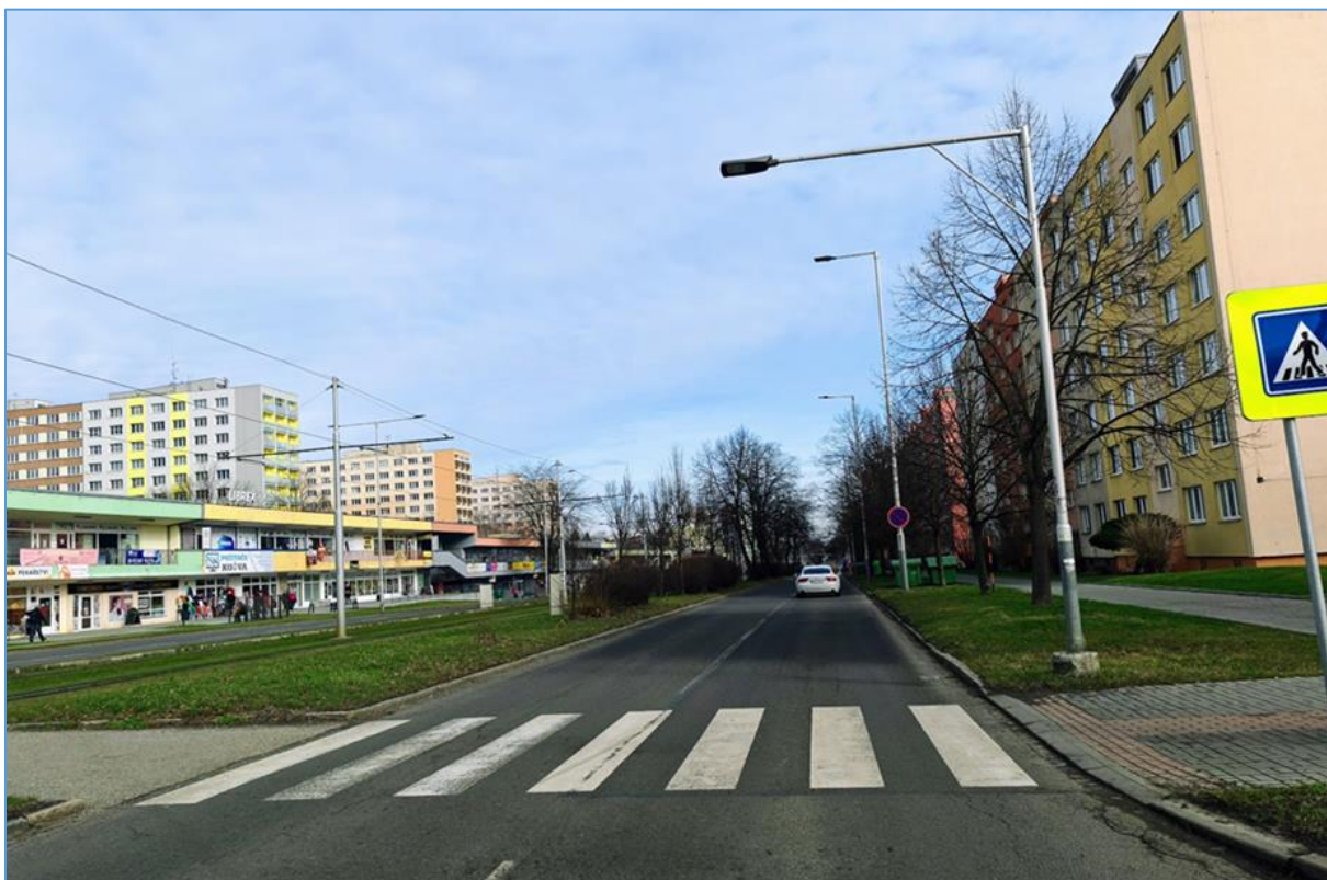
Obrázek 18: Kritické místo 2, Ostrava, ul. Výškovická (zdroj: vlastní fotodokumentace)
