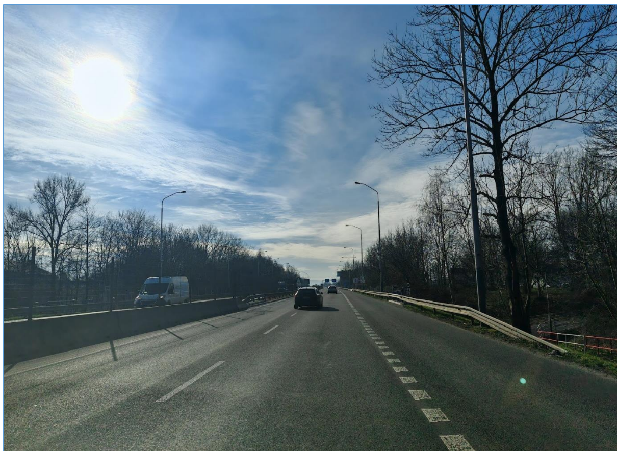
Obrázek 37: Kritické místo 8, Ostrava, ul. Míšecká (zdroj: vlastní fotodokumentace)
