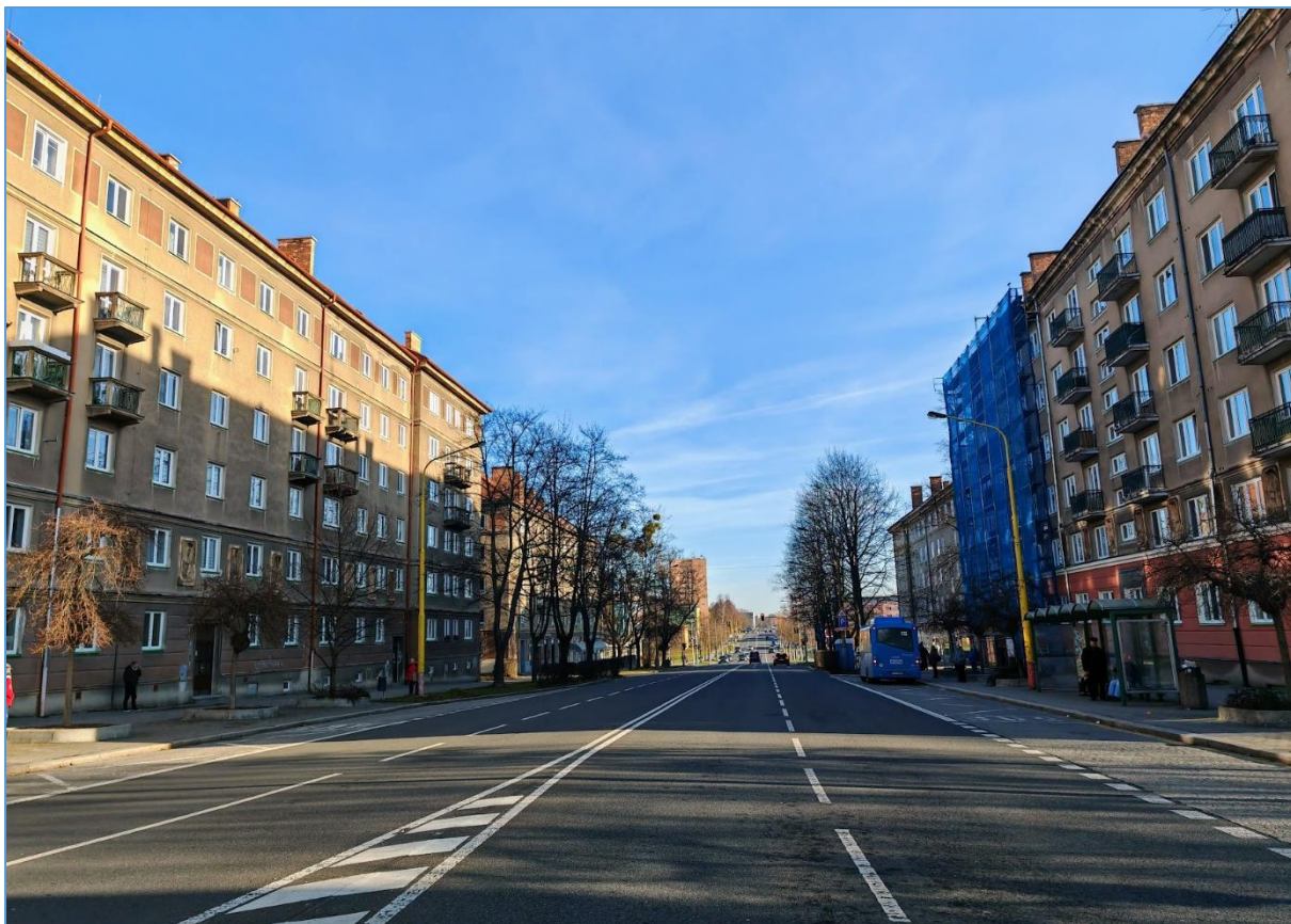
Obrázek 59: Kritické místo 14, Havířov, ul. Dělnická (zdroj: vlastní fotodokumentace)
