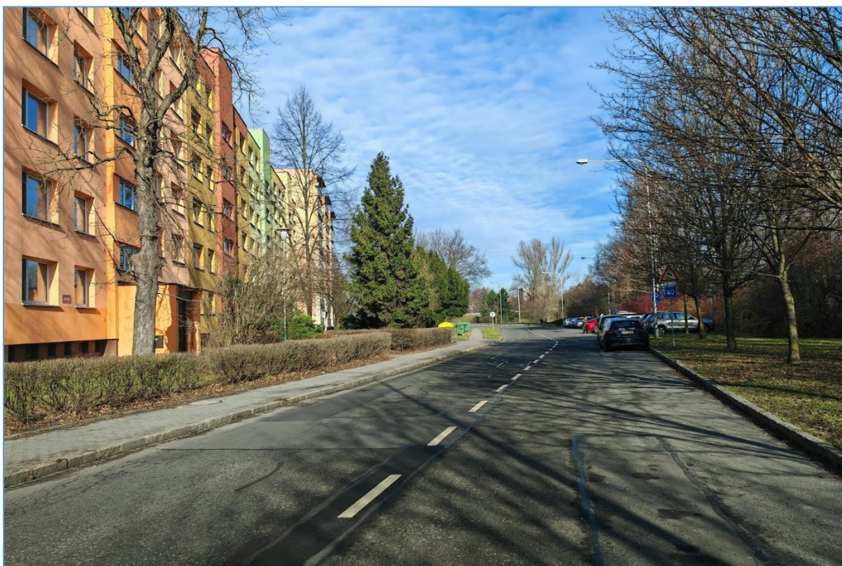
Obrázek 21: Kritické místo 3, Ostrava, ul. Aviatiků (zdroj: vlastní fotodokumentace)
