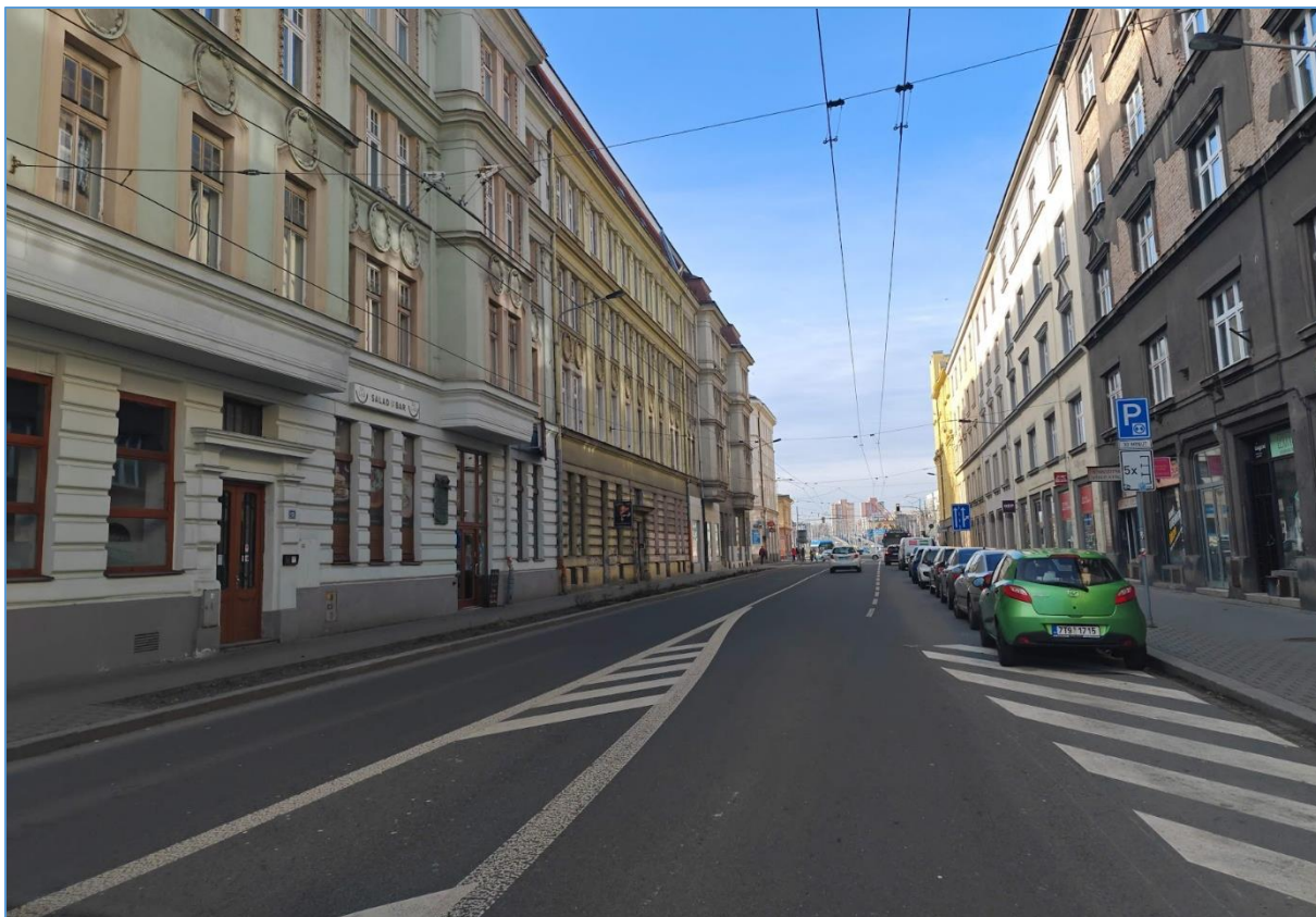
Obrázek 34: Kritické místo 7, Ostrava, ul. Českoobratrská (zdroj: vlastní fotodokumentace)
