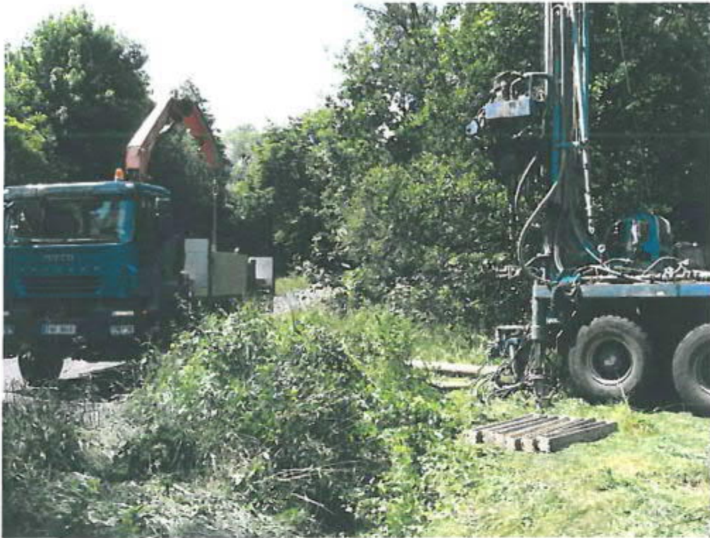
Obrázek č.21: plocha E1 - realizace vrtu NBN-15 v jižním rohu plochy E1, v trase plánované komunikace PK1.
