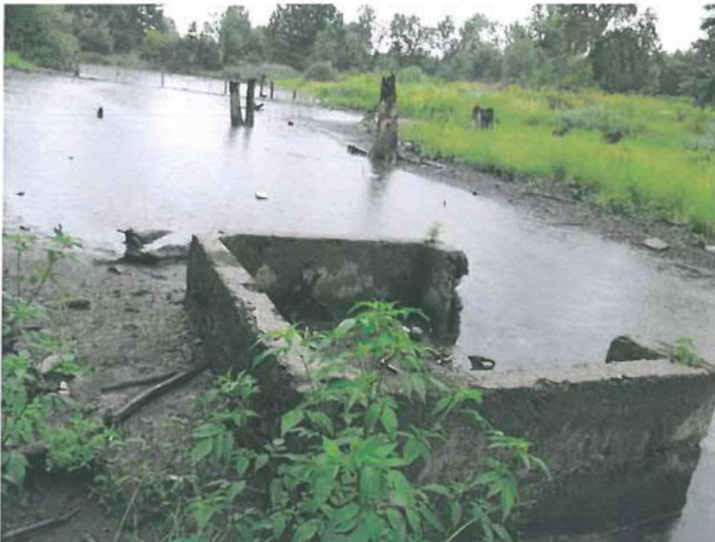
Obrázek č.7: plocha B - objekt neznámého určení v jižní části zátopy (nefunkční propust ?).
