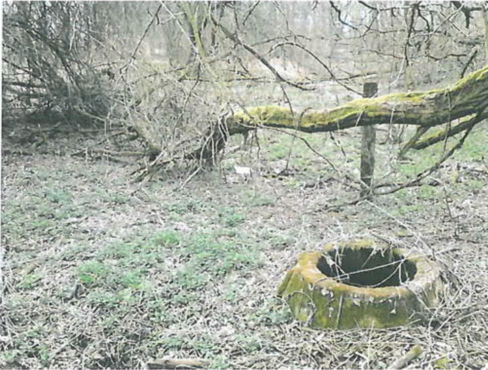
Obrázek č.13: plocha D - archivní snímek, patrně drenážní šachtice v prostoru bývalé těžebny cihlářských surovin.
