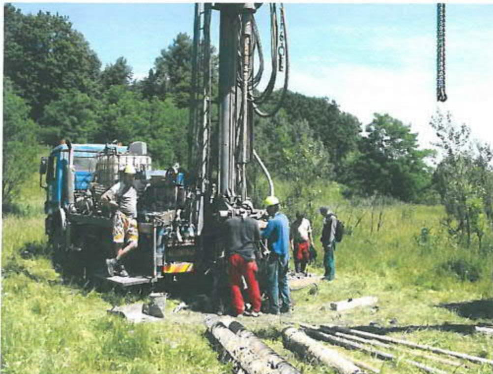
Obrázek č.18: plocha E - záběr z realizace vrtu NBN-4 v údolí Karvinského potoka, v pozici plánované ČOV.
