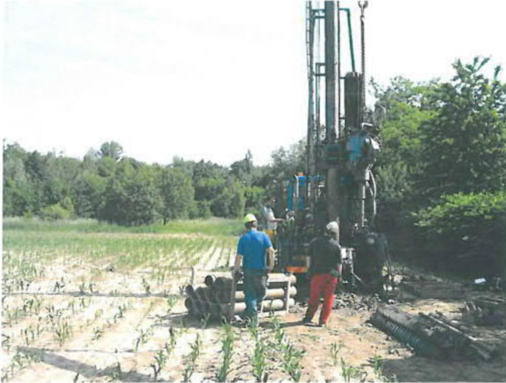
Obrázek č.1: plocha A - realizace průzkumného vrtu NBN-12 při hraně rekultivačního násypu.
