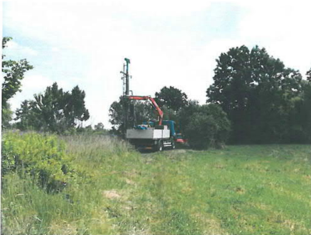
Obrázek č.9: plocha B - realizace vrtu NBP-9 v severní části plochy.
