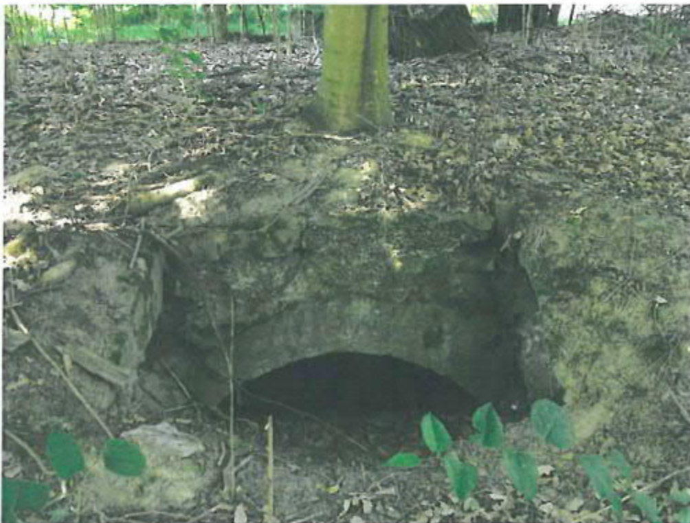
Obrázek č.16: plocha D - snímek zasypaného vstupu do podzemního prostoru, cca 50 m SZ od vrtu NBV-2. Rozsah prostoru ověřován georadarem.
