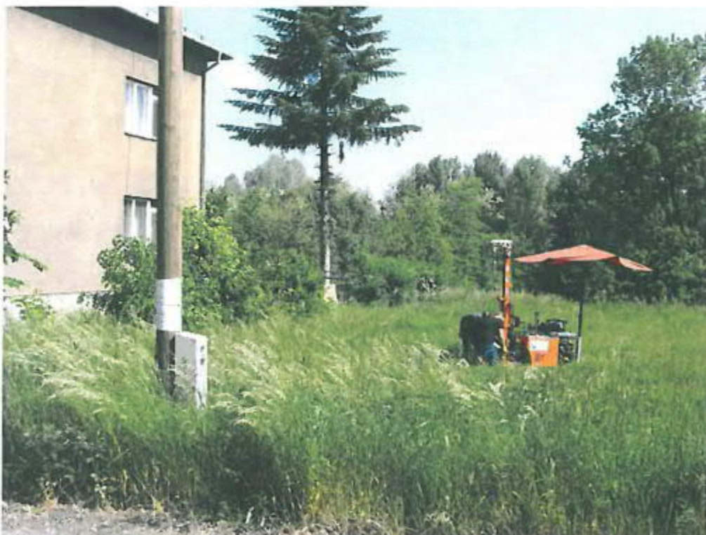
Obrázek č.8: plocha B - realizace sondy dynamické penetrace DP-7 při jižním okraji plochy B.
