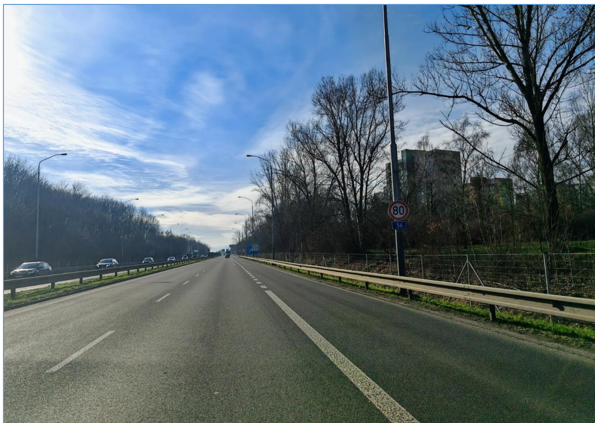
Obrázek 20: Kritické místo 3, Ostrava, ul. Míšecká (zdroj: vlastní fotodokumentace)
