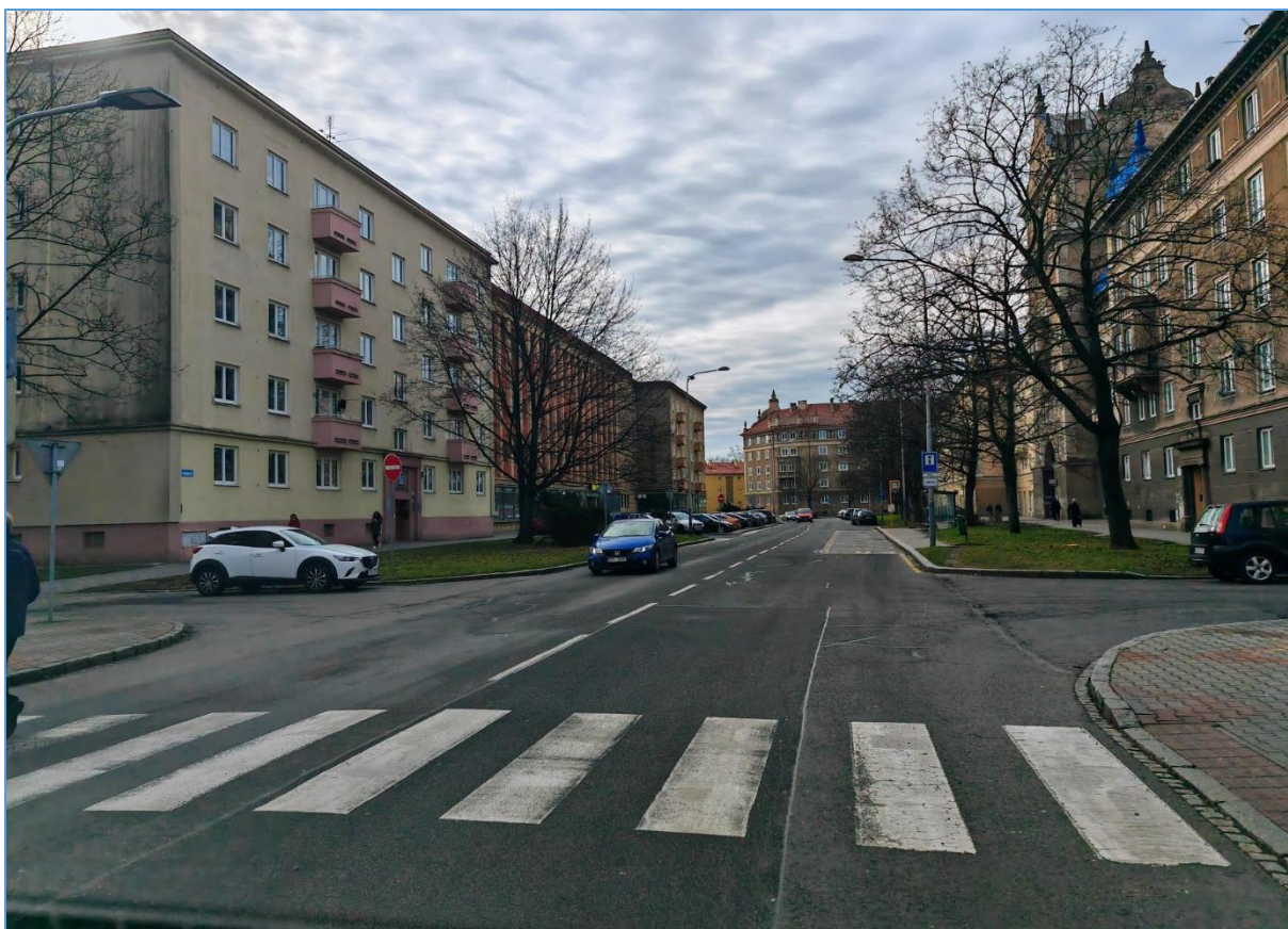
Obrázek 62: Kritické místo 15, Ostrava, ul. Porubská (zdroj: vlastní fotodokumentace)
