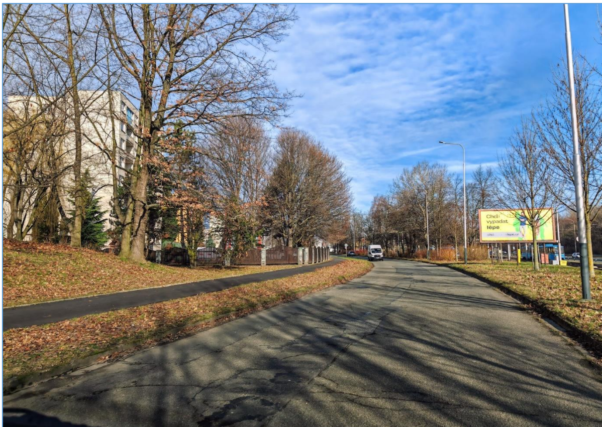
Obrázek 48: Kritické místo 11, Ostrava, ul. U Haldy (zdroj: vlastní fotodokumentace)
